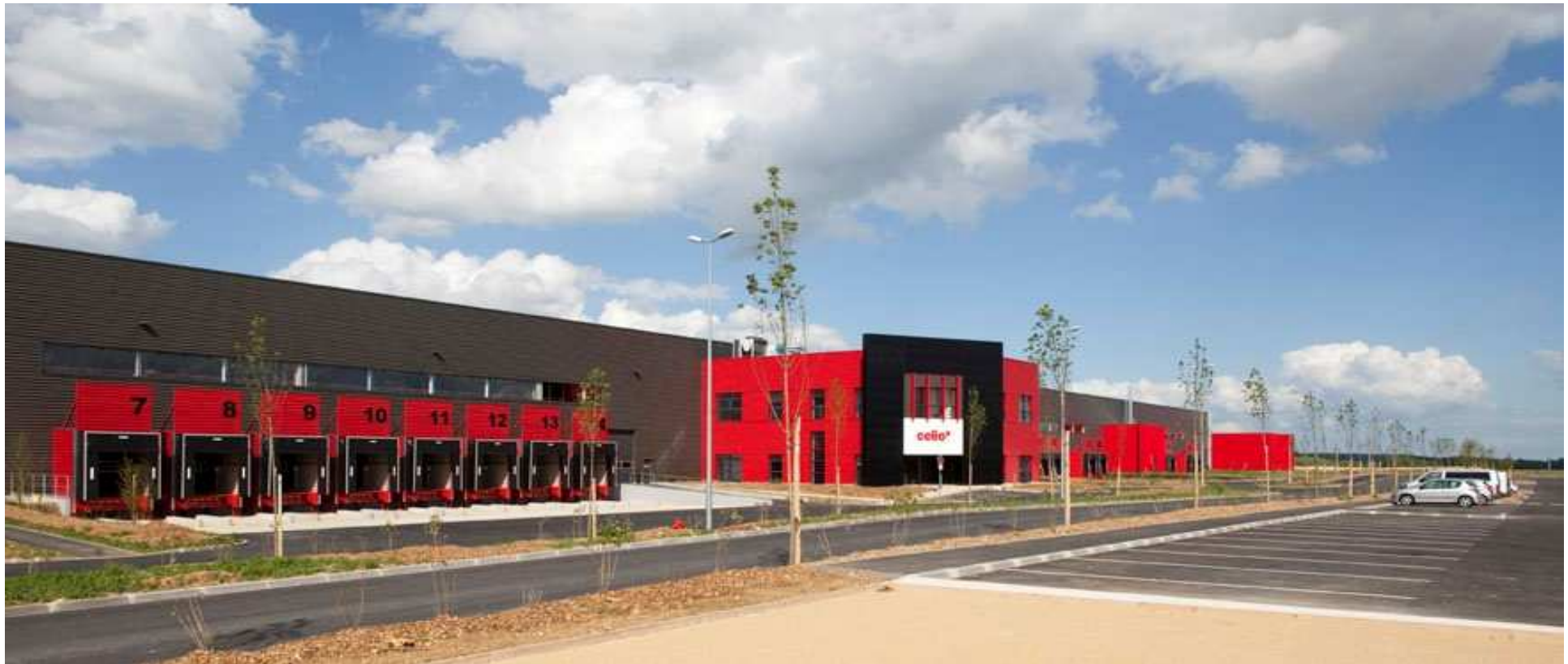
Plateforme Celio - Amblainville (60)
