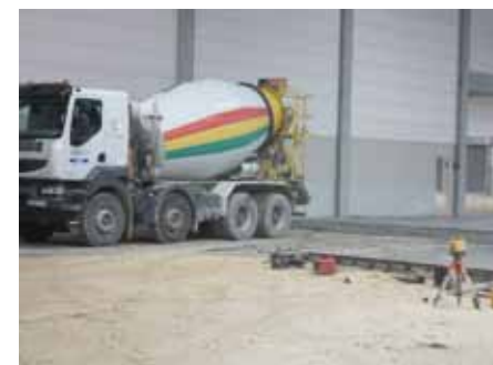
Fig. 5 : Coulage du béton
