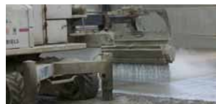
Fig. 7 : Épandage du durcisseur de surface
