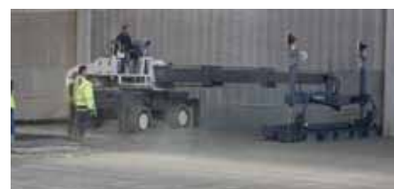
Fig. 6 : Lissage au Laserscreed
