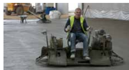
Fig. 8 : Talochage à l'hélicoptère
